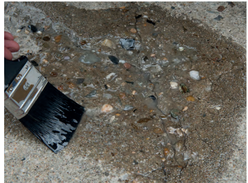
De beschadiging of zwakke ondergrond instrijken met behulp van een kwast
