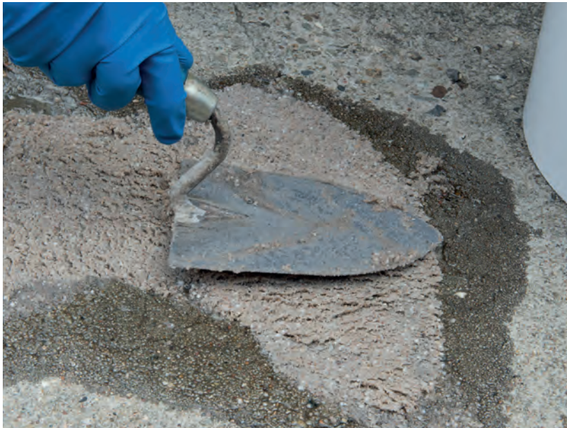
Epoxy mortel goed aandrukken op de ondergrondversterker
