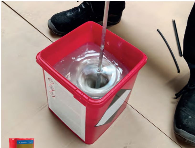
Mengen met mixer en Poxy DC toevoegen
