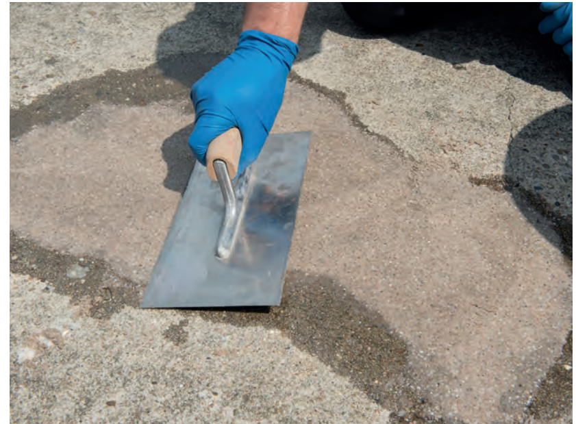
Gladstrijken met vlakspaan die lichtjes bevochtigd is met Poxy DC Indien supergladde toplaag gewenst, afdekken met PE folie en deze na uitharding verwijderen
