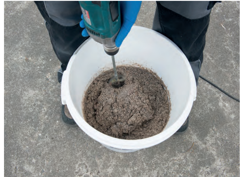
Meng deze bij laag toerental tot een homogene pasta Giet de homogene pasta over in een andere mengemmer en controleer de bodem op correcte vermenging
